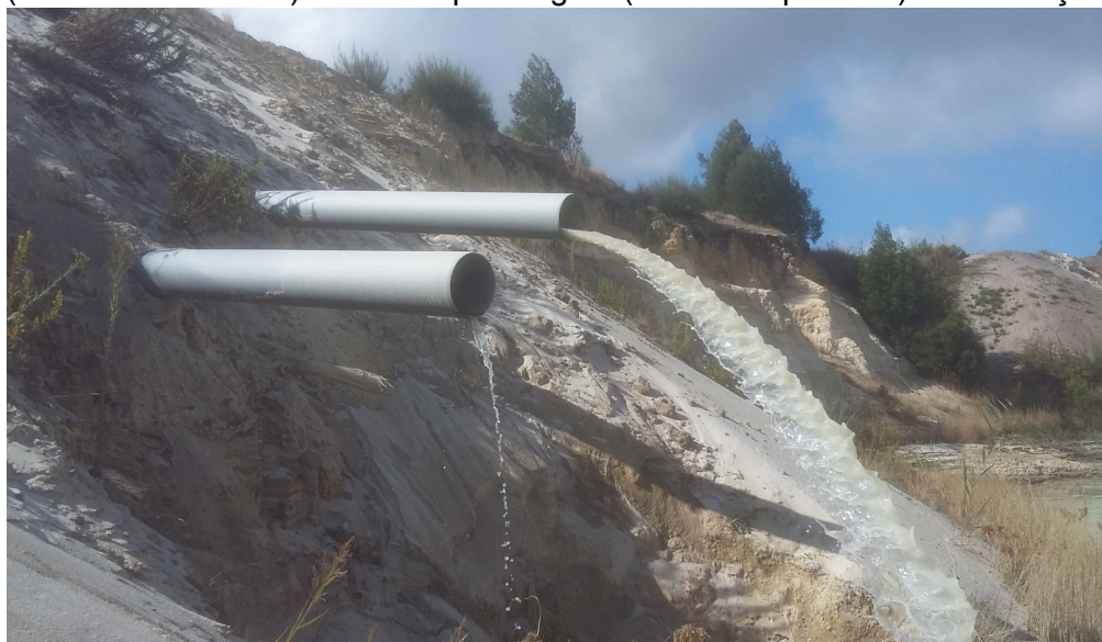
Fotografia 3.1.2 – Água libertada para a lagoa, a partir do tanque decantador-clarificador (tubo mais afastado) e da filtro-prensagem (tubo mais próximo) da instalação de caulinos.
